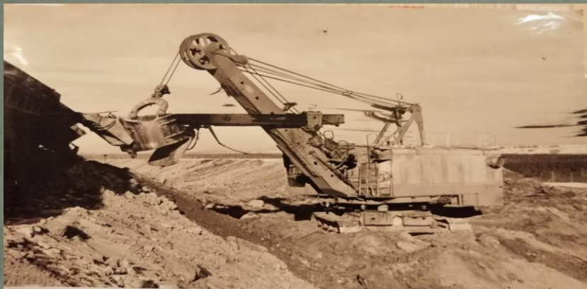
Очистка думпкара на отвале. 1980 г. МКУ «КГА» Ф. 1-К. Оп. 1-Ф. Д. 552.
